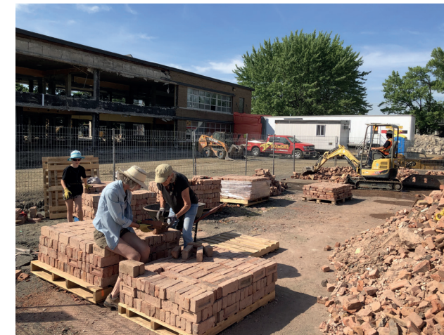
Le chantier est optimisé : il ya les cueilleurs qui ramassent les briques, les chargent dans des brouettes, les transporteurs qui les apportent aux trieurs qui répartissent les 3 catégories de briques en palettes. Fin juillet plusieurs tonnes de briques sont acheminées chez Couture Timbermart où elles sont désormais disponibles à la vente.
