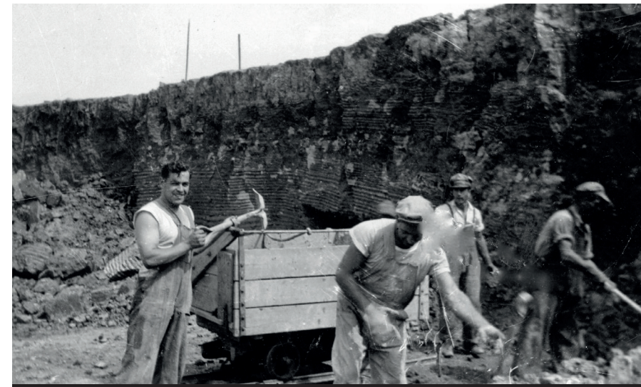
Bricade de Richmond, début des années quarante. Les briquetiers, à l'aide d'outils rudimentaires (pic et pelle), recueillent l'argile et autres types de sols qui serviront à la fabrication de belles briques rouges. On aperçoit Jean Beaudet, fils de Wilfrid, gérant de la production versant la matière dans un gros bac de bois. La briqueterie était située à l'extrémité de Janesville.
